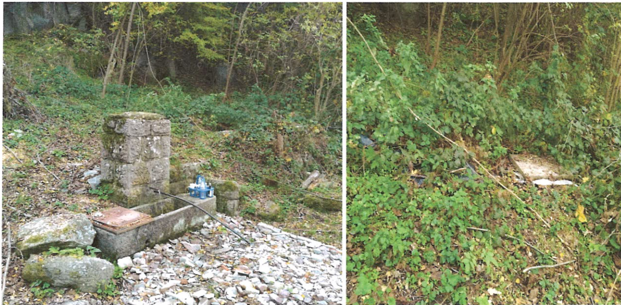
Слика 1. Каптажа са јавном чесмом
