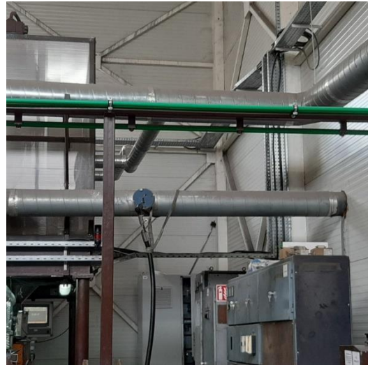
E2 - emiter usisne haube iznad glave ekstrudera – pogon masterbača
