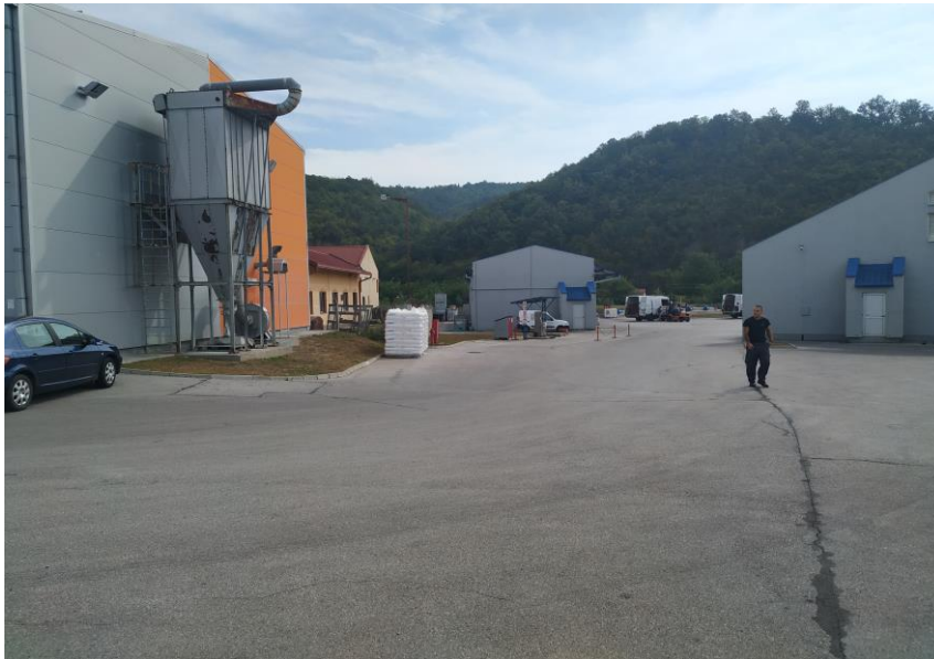
- Механички филтер отпашног система постројења за производњу мастербача -
