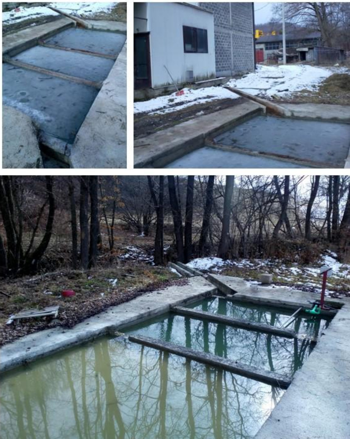
Слика бр.13: Вишекоморни таложни базени
