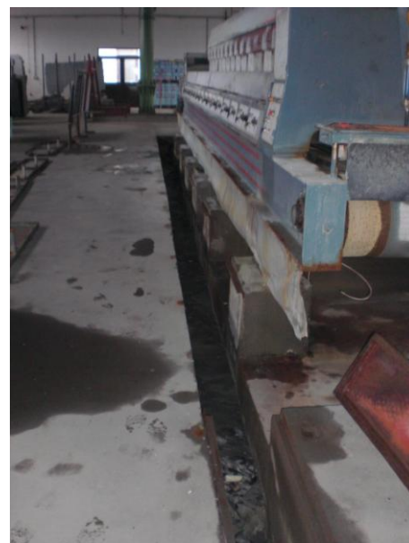
Слика бр.12: Сабирни канал за отпадне воде
