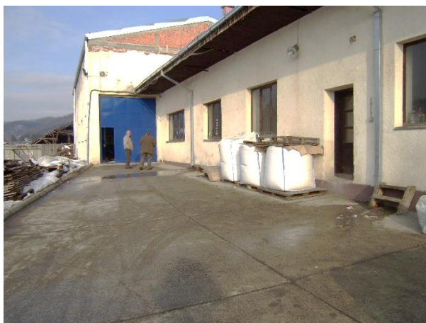
Slika 3.1. Izgled objekta gledano iz pravca dimnjaka
