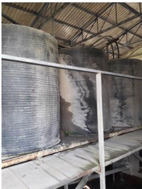
Slika 3.19: Izgled rezervoara za tretman vode koja se recirkuliše
