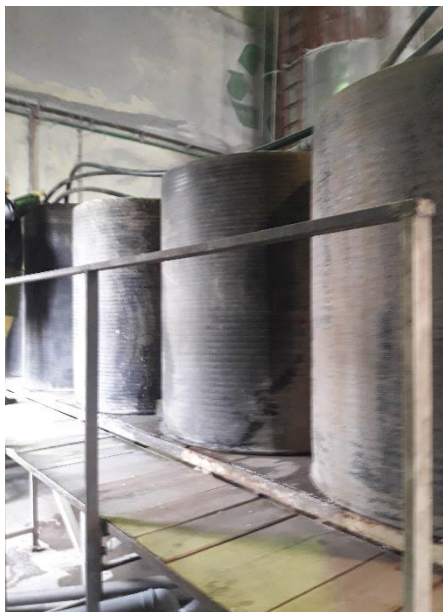
Slika 3.19: Izgled rezervoara za tretman vode koja se recirkuliše
