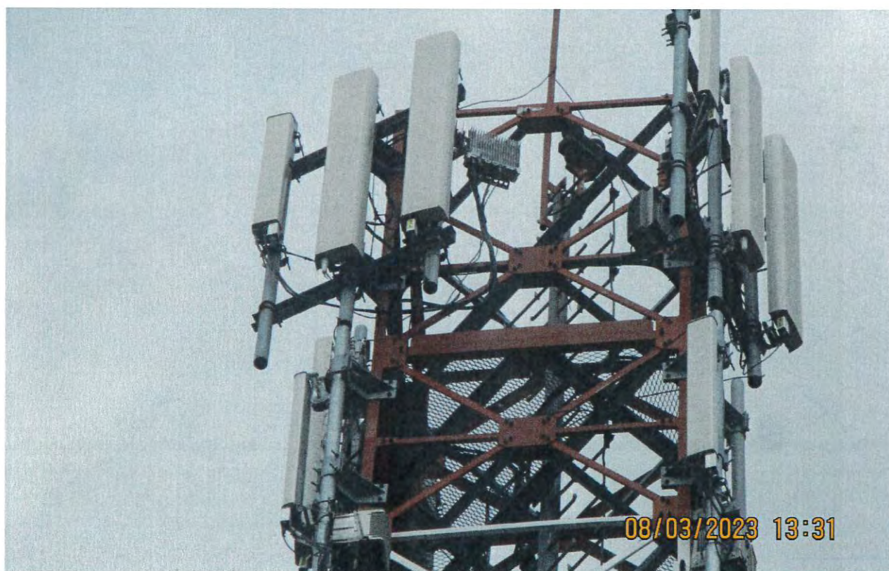
Slika 5 : Prikaz antena i radio modula sektora 2 BS Boljkovci operatora Telekom Srbija
